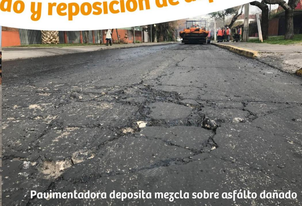
Pavimentadora deposita mezcla sobre asfalto dañado
